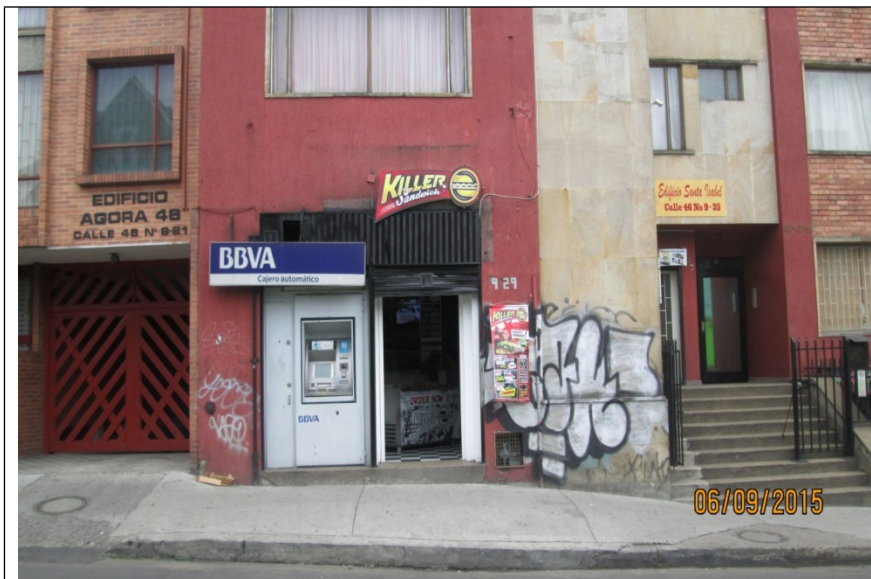
Fotografía No. 1: Avances del establecimiento KILLER SANDWICH, No cuenta con Registro de Publicidad Exterior Visual y no está permitido colocar avisos pintados o incorporados en cualquier forma a las ventanas o puertas de la edificación, ubicado en la Calle 46 No. 9 - 29.
